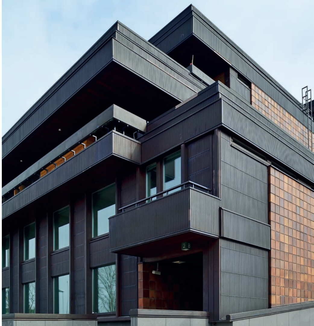
Kuparijulkisivu on korjattu kierrättämällä vanha julkisivumateriaali takaisin samaan kohteeseen. Materiaali valmistettiin tilaajan omasta raaka-aineesta.
