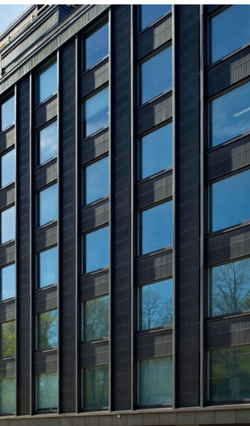
Kuparijulkisivu on korjattu kierrättämällä vanha julkisivumateriaali takaisin samaan kohteeseen. Materiaali valmistettiin tilaajan omasta raaka-aineesta.
